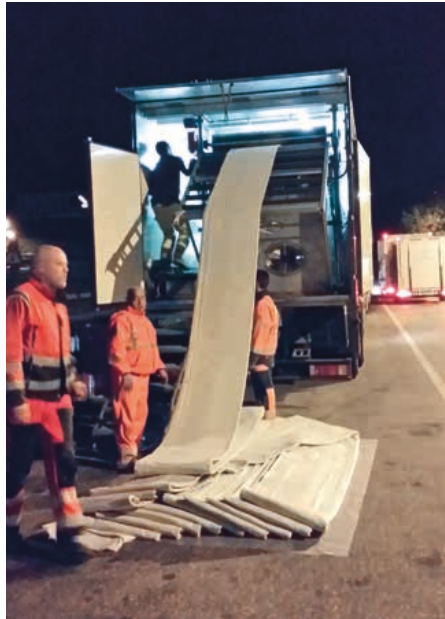
Links: Tränkung des VFG-Filzschlauches mit Harz, rechts: Einbau des VFG-Filzschlauches in das defekte Abwasserrohr | Fotos: VFG-lineTec
